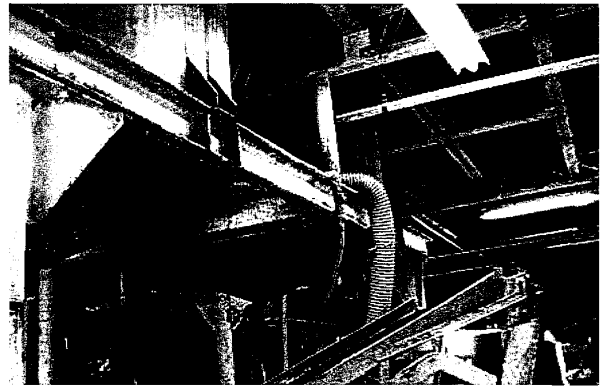
写真② 石鹼釜を工場一階から撮影 (2008年2月19日筆者撮影)
