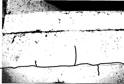
写真-4 フェアリング部のひび割れ
