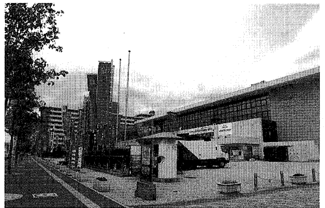
図-10 対象大規模建築物を含む周辺写真の例（延床面積10,000m 2 以上）
