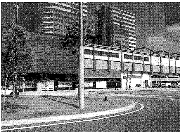
図-6 千早地区：対象建築物の例
