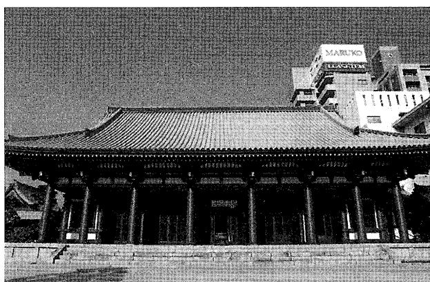
図-5 御供所地区：対象建築物の例
