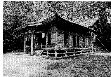
9、潮嶽神社拝殿・本殿
